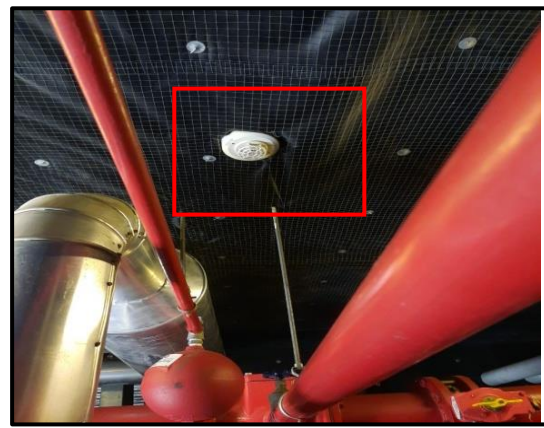
ภาพที่ 32 Heat Detector
