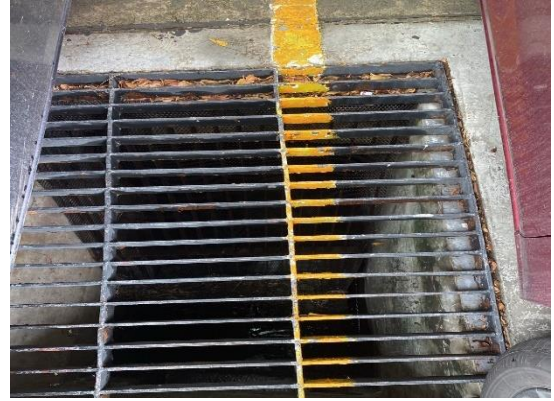
ภาพที่ 34 ตะแกรงดักขยะที่ Man Hole
