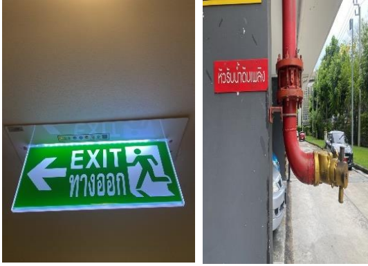
ภาพที่ 33 ป้ายบอกทางหนีไฟ, หัวรับน้ำดับเพลิง
